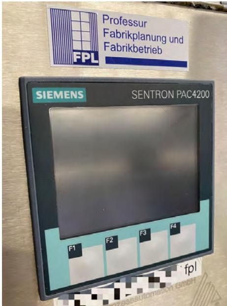
*Abb. 1: Multifunktionsmessgerät PAC4200*
